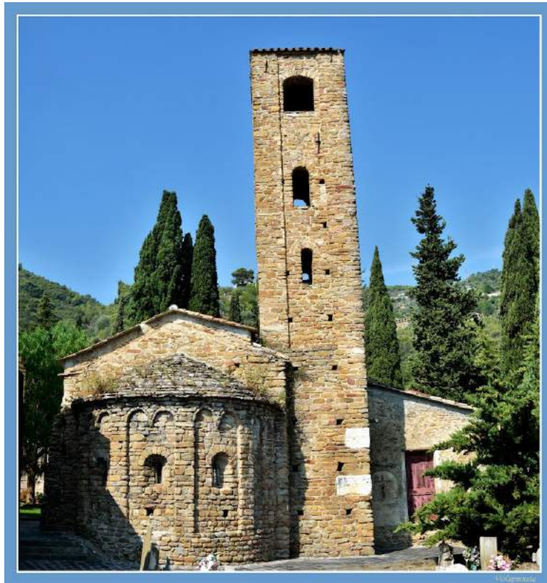
Fig. 23. La chiesa di San Pietro a Camporosso. Parte absidale e campanile
