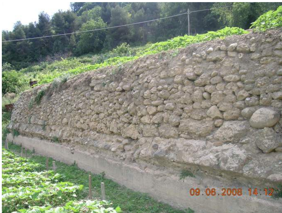
fig. 21. Tratto dell'antico acquedotto inglobato in un muro di fascia (foto H. De Sanctis, Relazione attività svolte , Archivio Soprintendenza)
