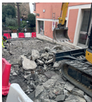
Rifacimento sede stradale in via Di Pettinengo
