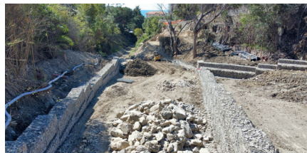
Lavori "Secondo Lotto" contro il dissesto idrogeologico del Rio Crosio
